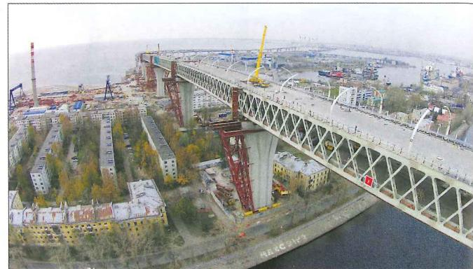
В ходе монтажа пролетное строение надвигалось на расстояние больше километра, в итоге было надвинуто более 20 тыс. т металла, что является уникальным достижением для мирового мостостроения.
